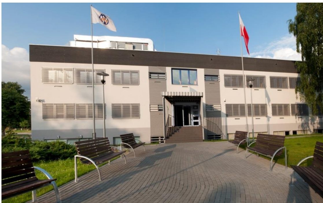
Foto 2. Budynek główny część C
